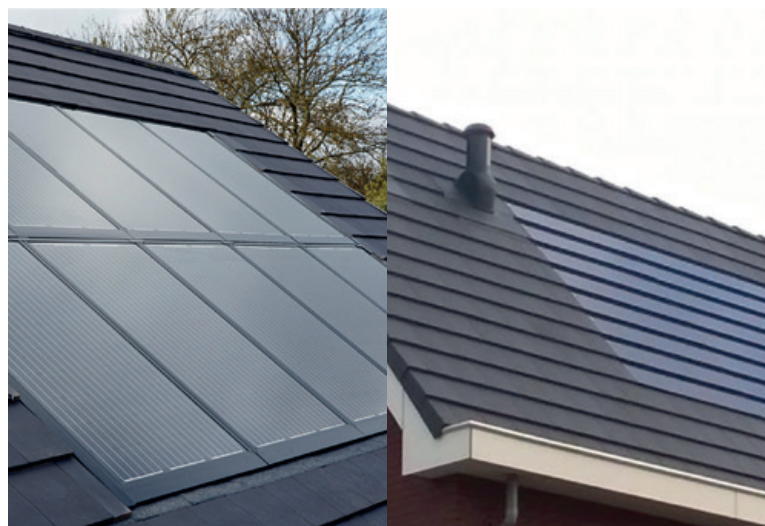
Figuur 10: In het dak geïntegreerde zonnepanelen.
